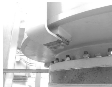
图5 CT法兰面优化设计
